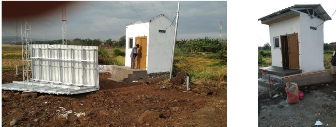
Gambar 4. Kondisi rumah daya sebelum dan sesudah perbaikan
