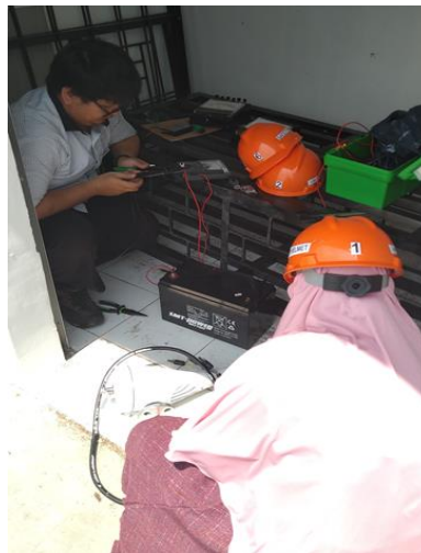
Gambar 2. Perawatan dan pengecekan fungsi baterai.
