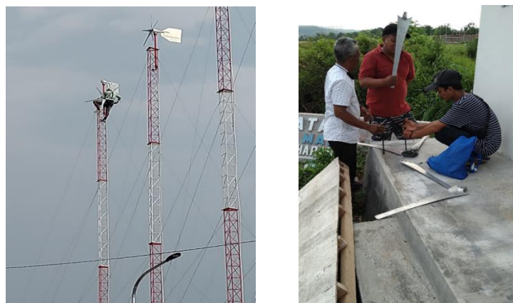
Gambar 6. Pengambilan turbin angin dan perbaikan sudu-sudu
