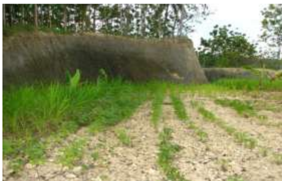
Gambar 3. Terasering Kegiatan Reklamasi
