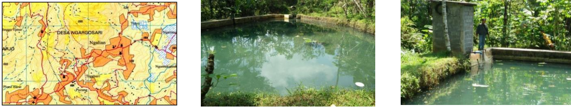
Gambar 11. Lokasi dan kondisi eksisting potensi sumber daya air baku mata air Sumber Cangkring
