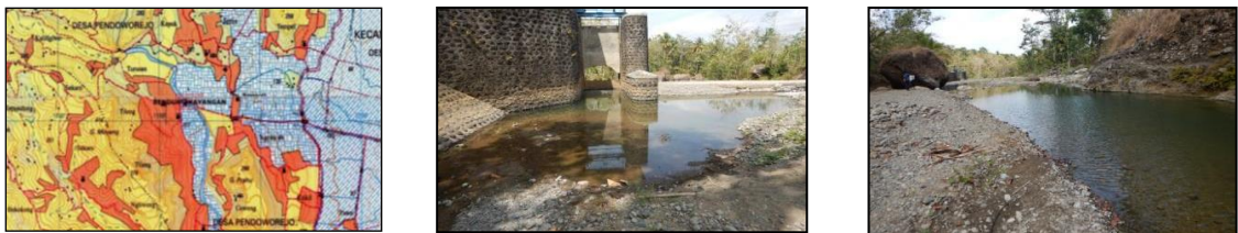
Gambar 6. Lokasi dan kondisi eksisting potensi sumber daya air baku bendung Kayangan
