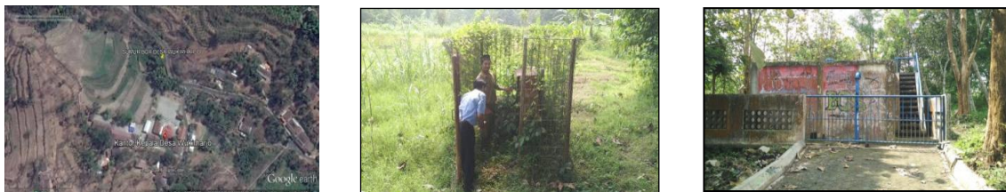
Gambar 8. Lokasi dan kondisi eksisting potensi sumber daya air baku sumur bor Wukirharjo
