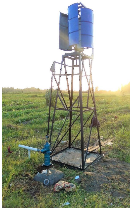
Gambar 4. Pemasangan kincir angin dan seluruh komponen di lahan pasir
