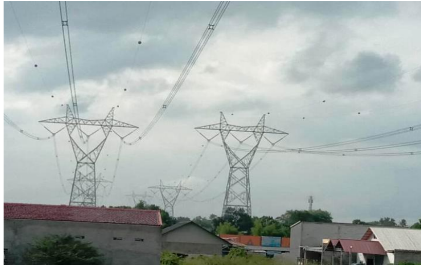
Gambar 1. Sekelompok Rumah Berada di bawah SUTET dgn tower Konfigurasi Horizontal, 2 Kawat Tanah, Rangkaian Tunggal.
