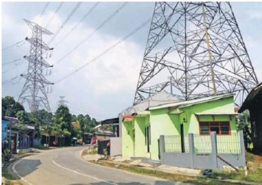
Gambar 2. Jaringan SUTET-500 kV, Konfigurasi Vertikal, Rangkaian Ganda, di atas jalan dan di atas rumah penduduk setempat
