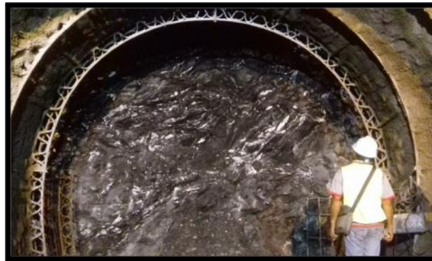
Gambar 7. Kondisi batuan face Tunnel lokasi pore boring
