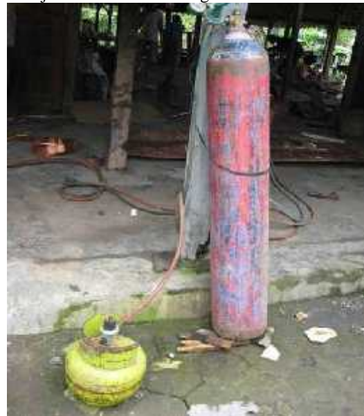
Gambar 1. Instalasi las asetelin yang dimodifikasi dengan tabung LPG.
