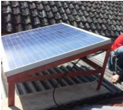
Gambar 10. Modul Solar Panel dengan Kemiringan 20°
