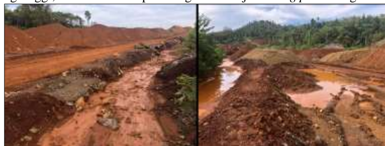
Gambar 7. Kondisi Paritan Stockpile
