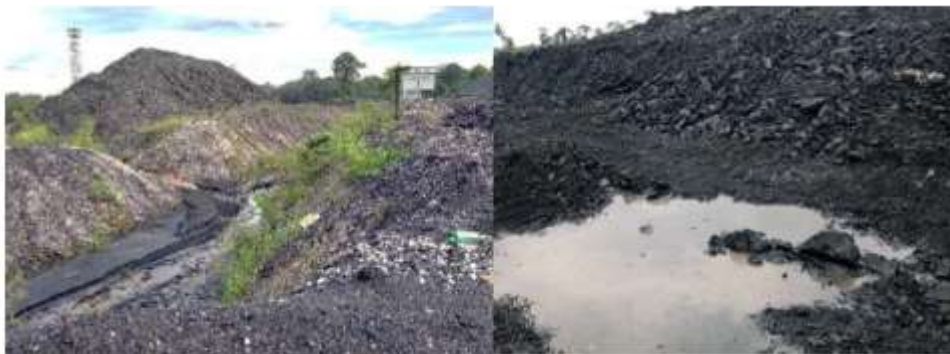
Gambar 7. Saluran drainase dan Kontaminasi di stockpile
