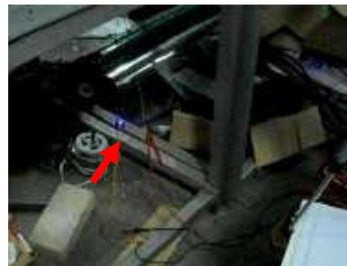
Gambar 17. Pemasangan kabel pada generator ke lampu LED.
