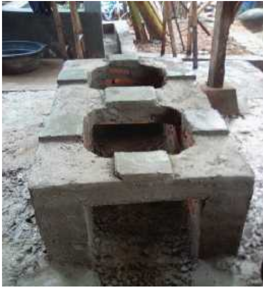
Gambar 4. Pembuatan tungku
