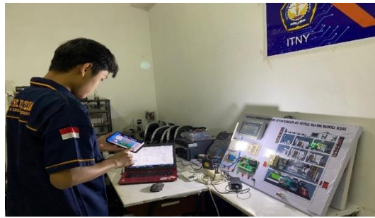
Gambar 10. Pengujian sistem kWh Meter PZEM-004T CT
