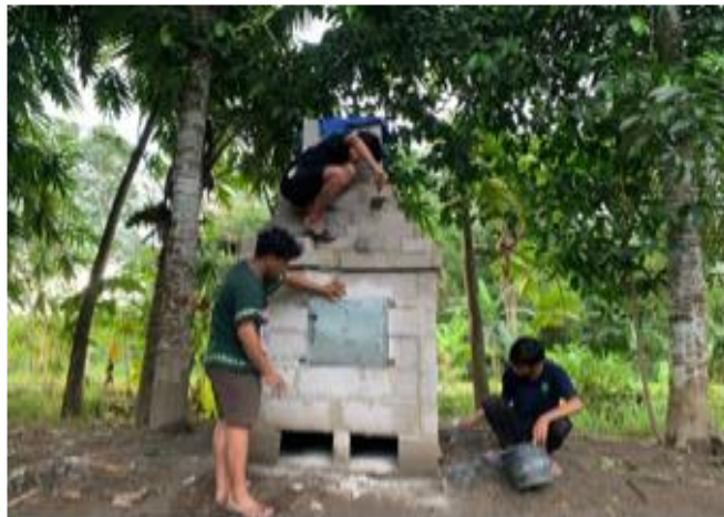
Gambar 8. Proses pemasangan pintu untuk tungku pembakaran sampah
