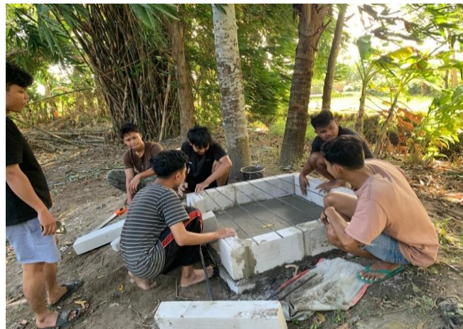
Gambar 5. Pemasangan Heibel dan besi
