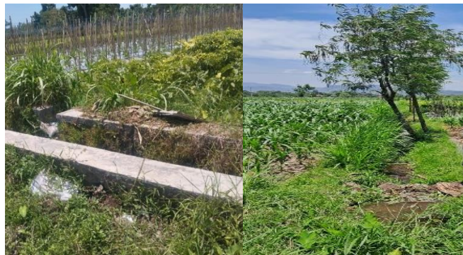
Gambar 2. Kondisi Eksisting Saluran
