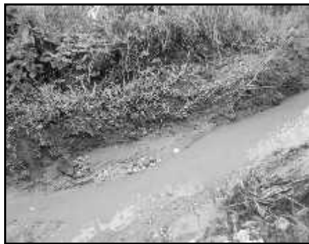
Gambar 4 Air Limpasan dari Jalan yang Mengalir Melalui Sodetan pada Kolam
