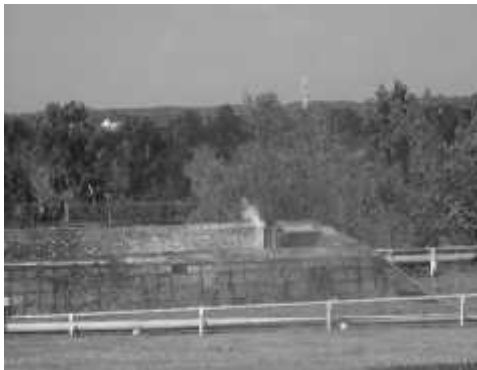
Gambar 4. Burn Pit (Unit Suar Bakar)
