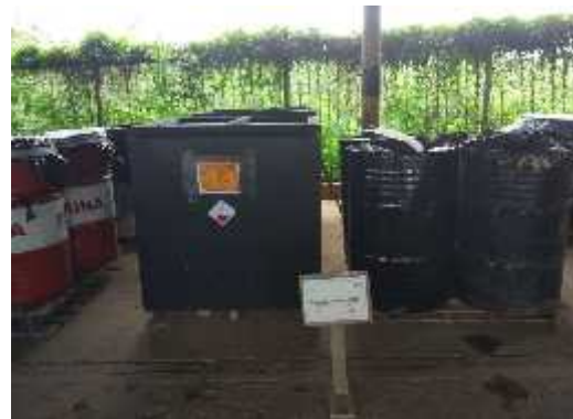
Gambar 2. Kondisi Eksisting Drum simbol dan label penyimpanan sementara lokasi B (Sumber data Primer, 2017)
