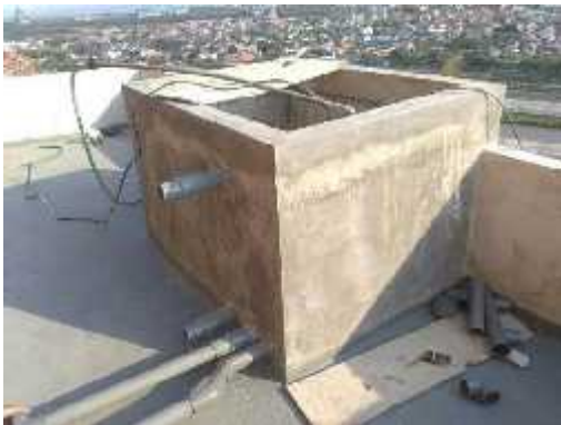
Gambar 15. Rangka hollow yang telah dirangkai menjadi satu bentuk untuk corong cyclone
