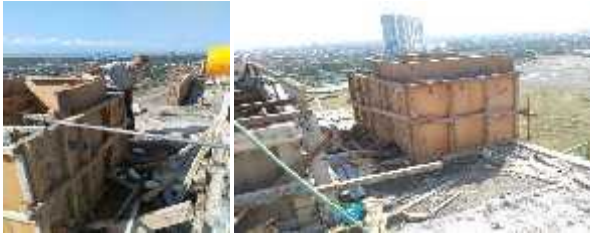
Gambar14. Pemasangan bekisting untuk pengecoran
