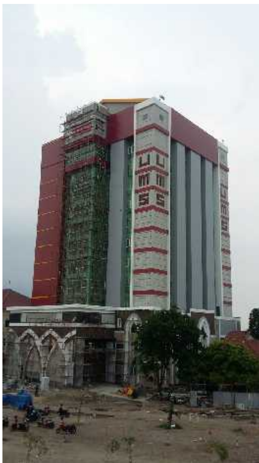
Gambar 19. Tampilan Gedung At-Tauhid Tower dari sisi lain
