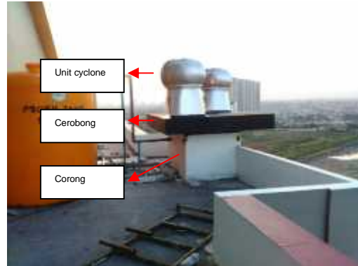
Gambar 17. Hasil Akhir Realisasi Pemasangan Desain dengan Konfigurasi 2 Cyclone
