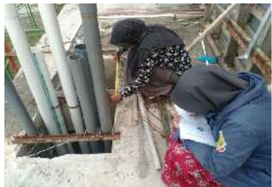
Gambar 13. Proses pembuatan Shaft di atas lantai 14
