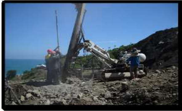
Gambar 1. Pemasangan Batang Bor
