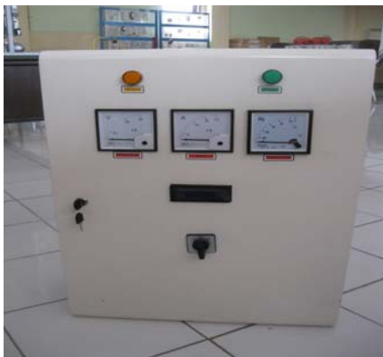
Gambar 4. Panel Sistem pengontrolan genset jarak jauh melalui website berbasis Mikrokontroler Arduino Mega 2560-16AU
