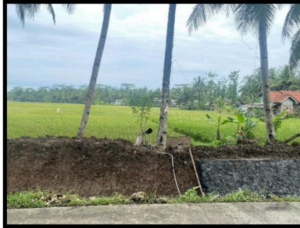
Gambar 7. Pemanfaatan Breksi Andesit Jampang untuk selokan/parit air.
