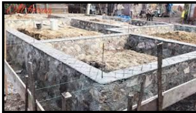
Gambar 8. Pemanfaatan breksi andesit Jampang untuk pondasi rumah.
