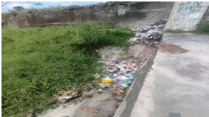
Gambar 1. Penumpukan sampah di dekat Sabo Dam
