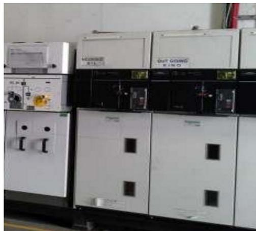
Gambar 11. Medium Voltage Distribution Panel (MVD) setelah *retrofitting*
