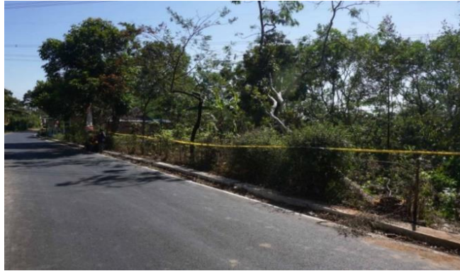
Gambar 2. Lokasi di bawah SUTET yang telah dipasang Police-Line
