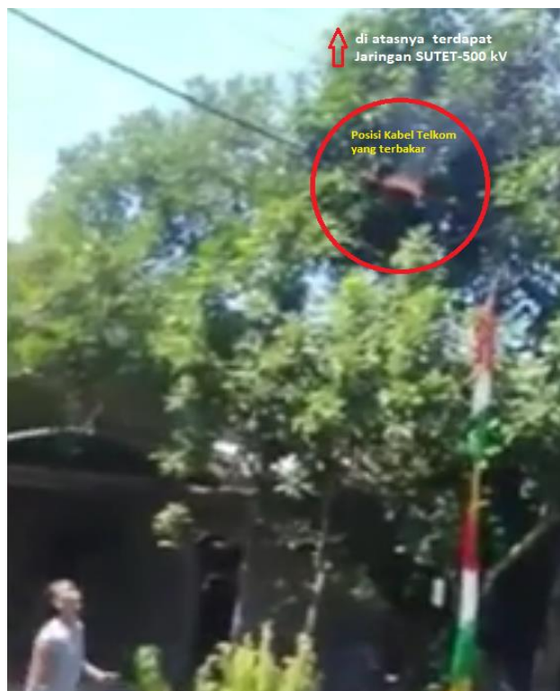
Gambar 5. Tembus-Listrik ( breakdown ) dari konduktor SUTET-500 kV, berlanjut dgn. kebakaran kabel Telkom (video pd segmen durasi detik ke 53) [5]
