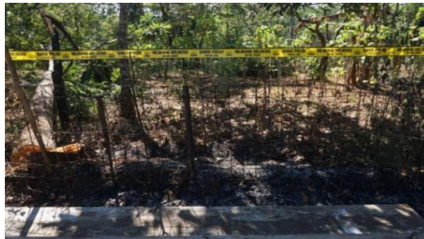
Gambar 1. Terjadi ledakan sebanyak lima kali, sejumlah lahan dan kabel ikut terbakar [3]
