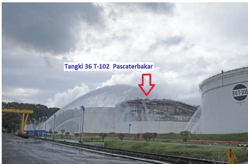
Gambar 2. Kondisi Tangki 36 T-102 yang terbakar berdampingan dgn Tangki 36 T-101 yang terselamatkan dari kebakaran
