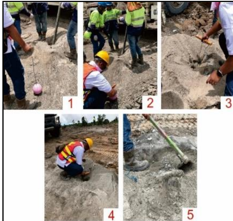
Gambar 3. Cara Pemasangan Ball Deck
