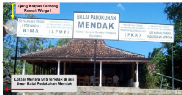
Gambar 2. Posisi Balai Pedukuhan Mendak terletak 3 – 17 meter sisi barat dari titik Poros Menara BTS
