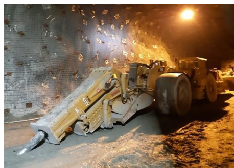
Gambar 4. Mobile Rock Breaker Melakukan Persiapan Kerja
