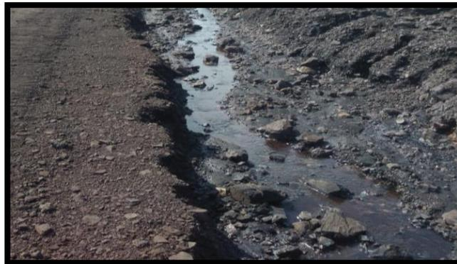
**Gambar 10.** Perbaikan Saluran Terbuka (Paritan)
