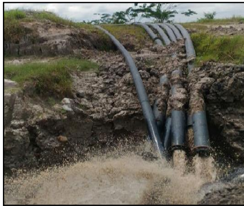
Gambar 5. Proses Pemompaan Air Asam Tambang Dari Sump
