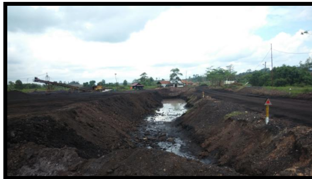
Gambar 6. Perbaikan Saluran Terbuka (Paritan)
