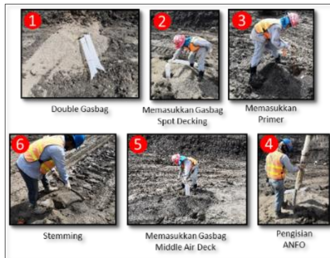
Gambar 4. Tahapan implementasi ide perbaikan diameter 6 1/4 dengan spot decking
