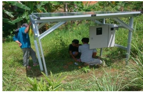
Gambar 4. Kegiatan pemasangan PLTS sebagai sumber energi sistem irigasi otomatis
