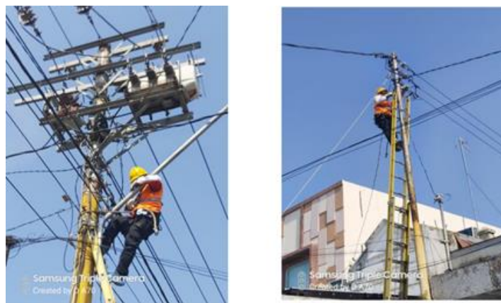
Gambar 3. Dokumentasi pelaksanaan pengukuran sebelum dan setelah penyeimbangan beban.
